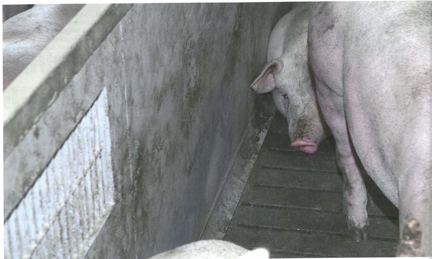
Hulkelliste i overgangen mellem gulv og inventar forbedrede ikke rengøringsmulighederne. Foto: Torben Jensen, Seges.
